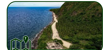
SEA WALL DAMPULAN, TORRIJOS
